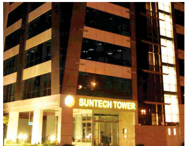
SUNTECH TOWER UAE
